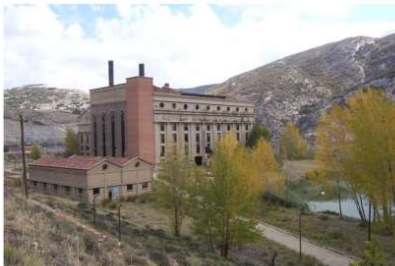
Ilustración 07. Vista general del edificio de la central. Foto Carlos Colás
