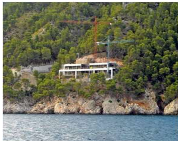
La vivienda unifamiliar de lujo que Alfonso Cortés construyó en Formentor. / D.O.M.
