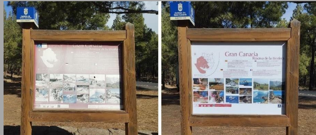
Sustitución de paneles en Llanos de la Pez (Tejeda).
