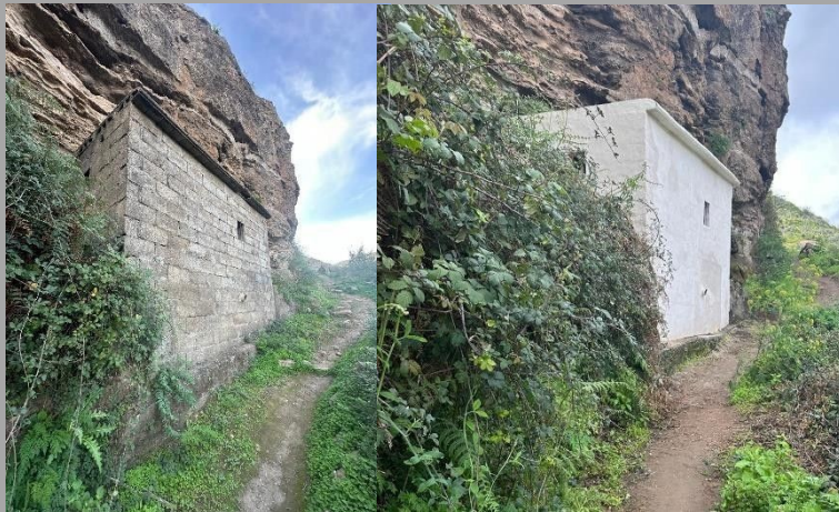
Restauración de la Cantonera en el camino a Risco Caído (Artenara)
