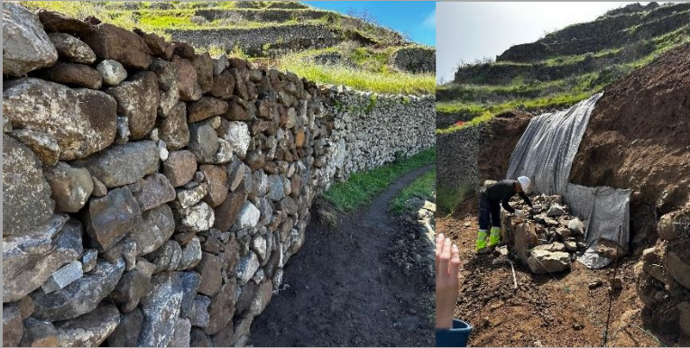
Reconstrucción de Bancales (Artenara)
