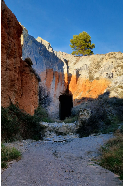
Túnel de la mina Daroca
